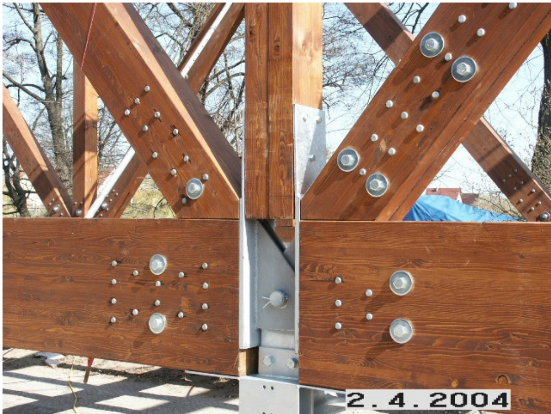
Pionierbrücke in Templin, vormontiertes Gelenk, Holzfachwerk mit verzinkten Stahleinbauteilen
