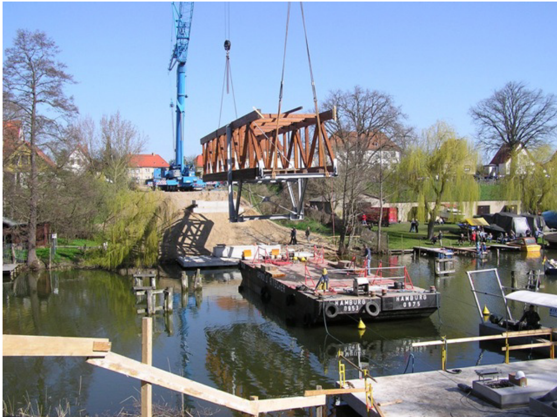
Pionierbrücke Templin, Montage, (fertige Brücke siehe hinten)
